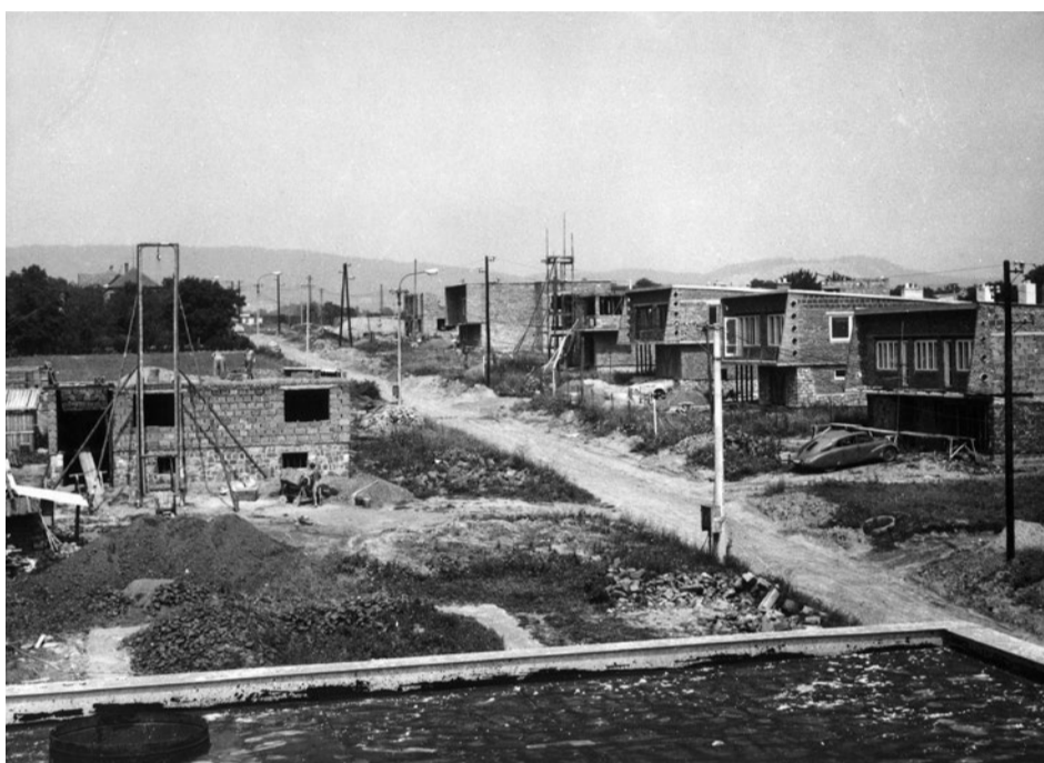
Výstavba nové vilové čtvrti, ulice Nerudova (70. léta)
