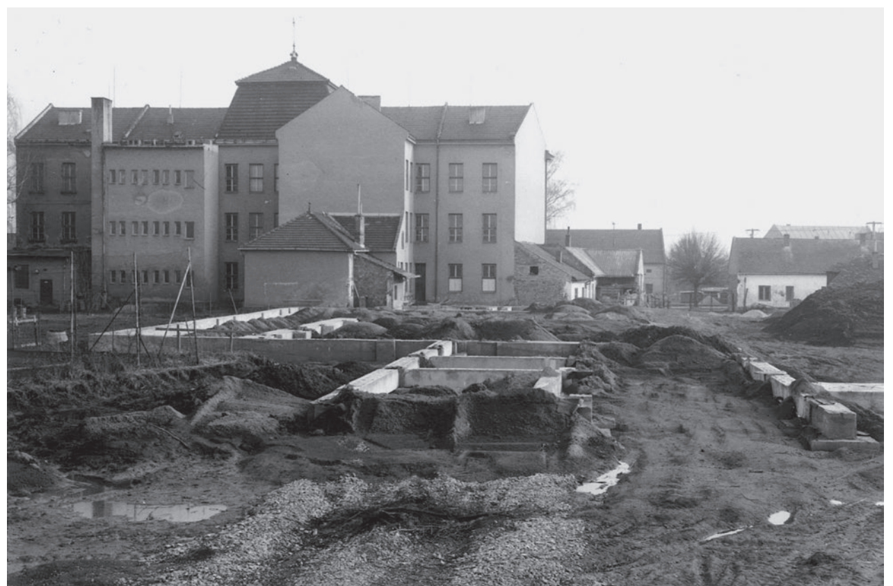
Začátek výstavby multifunkční tělocvičny vedle školy v r. 1990
